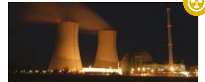
Contrôle des accès de sites nucléaires
